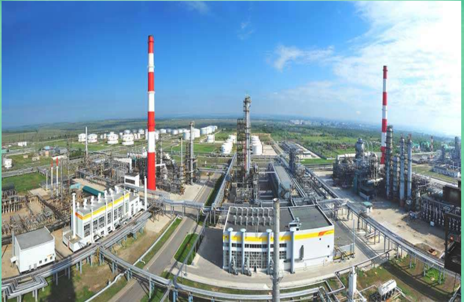
Нефтеперерабатывающий завод в Самарской области г. Сызрань
